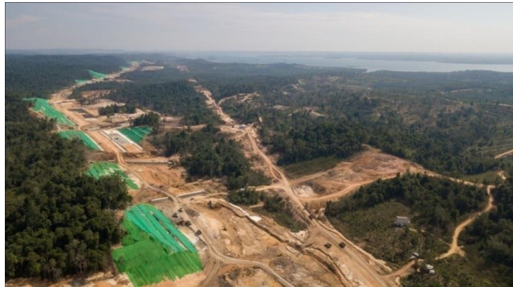
Pracovníci pokračují v kácení, zárovnávání půdy, výstavbě odvodňovacích kanálů a v umístění podpůrných sloupů pro mýtnou cestu i v místech, které měla být ponechána v původním stavu.
